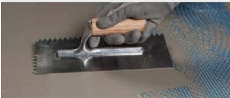
Stesura della prima mano di **Mapelastic Turbo** ed inserimento di **Mapenet 150**
