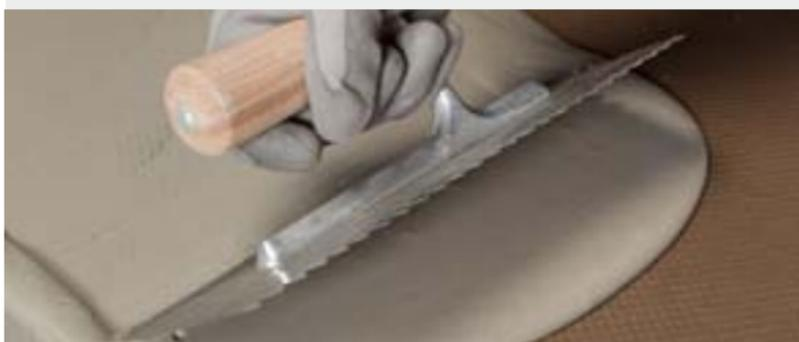
Stesura della seconda mano di **Mapelastic Turbo**
